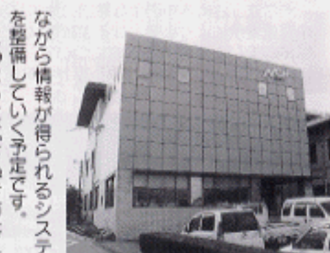
長尾町のCATVの中核NCNセンター
