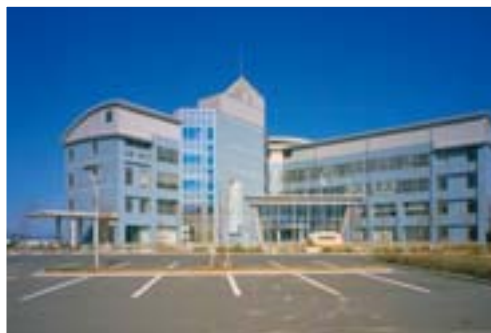
さぬき市役所本庁舎
