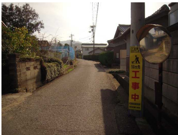
水道管布設道路(着工準備中)
