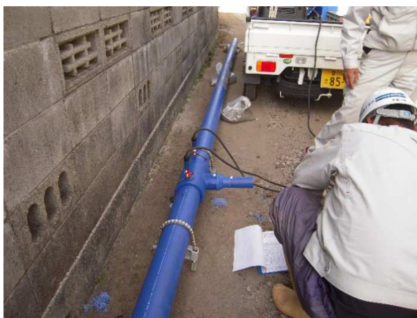
ポリエチレン管Φ100mm 電気融着接合中
