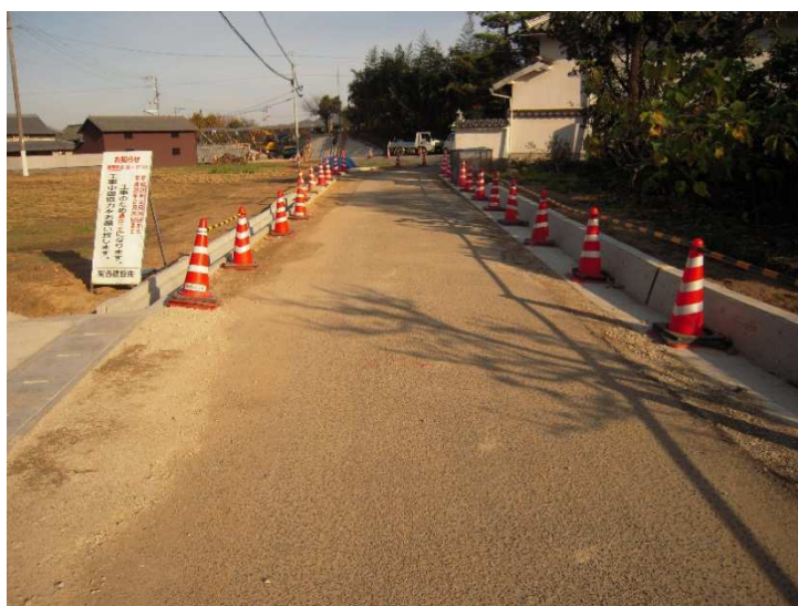
L 型側溝と U 字溝の施工状況
