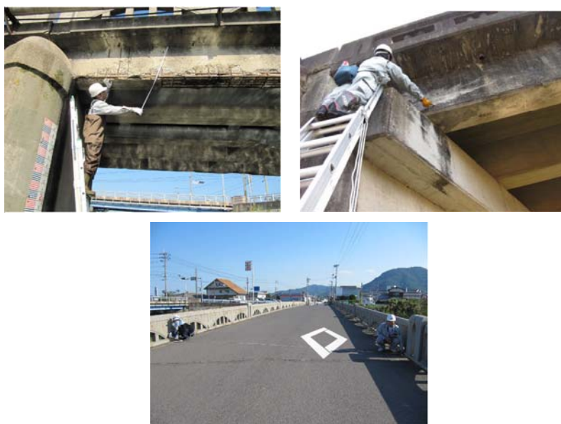
図 3.1 定期点検の様子
