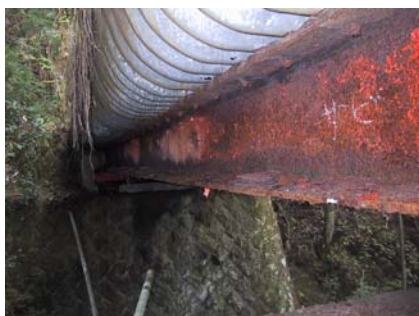
図 1.3 鋼橋の損傷状況
