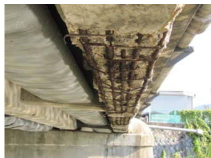
図 1.4 コンクリート橋の損傷状況
