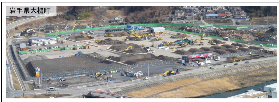
図 2-6-(6)-3 二次仮置場の例
