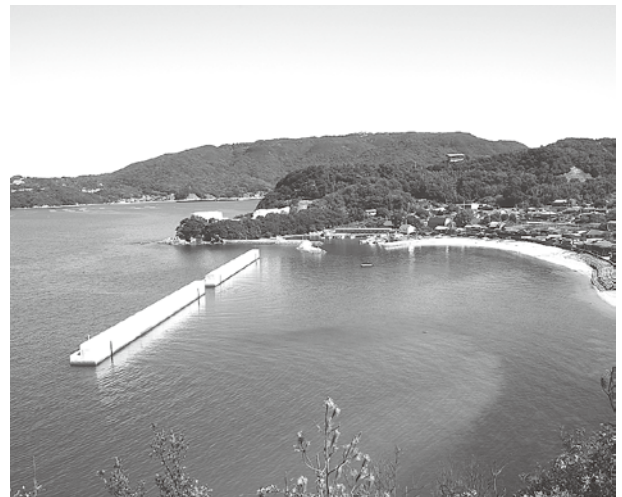
完成した苫張海岸離岸堤
