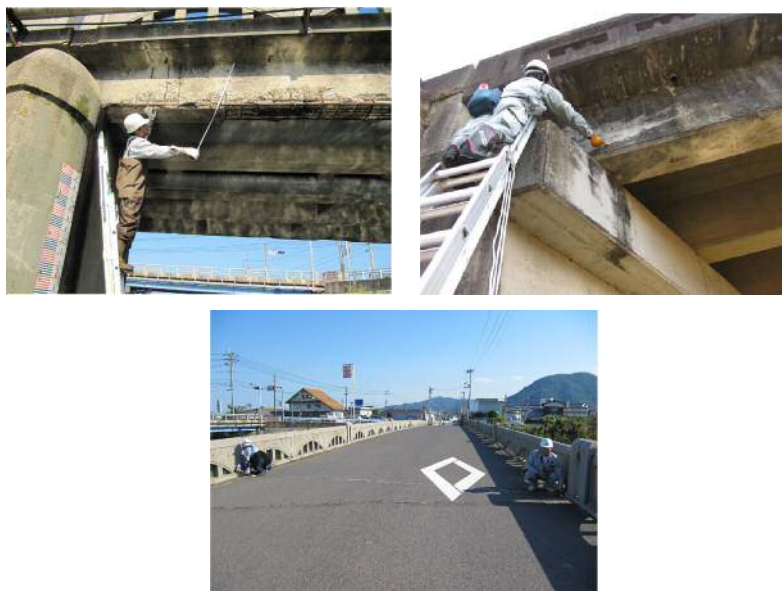
図 3.1 定期点検の様子
