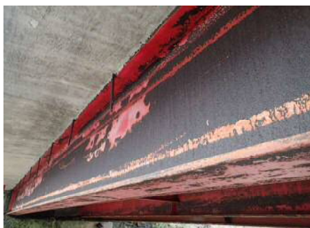
図 1.3 鋼橋の損傷状況
