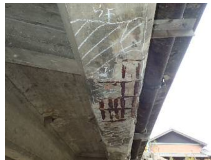
図 1.4 コンクリート橋の損傷
