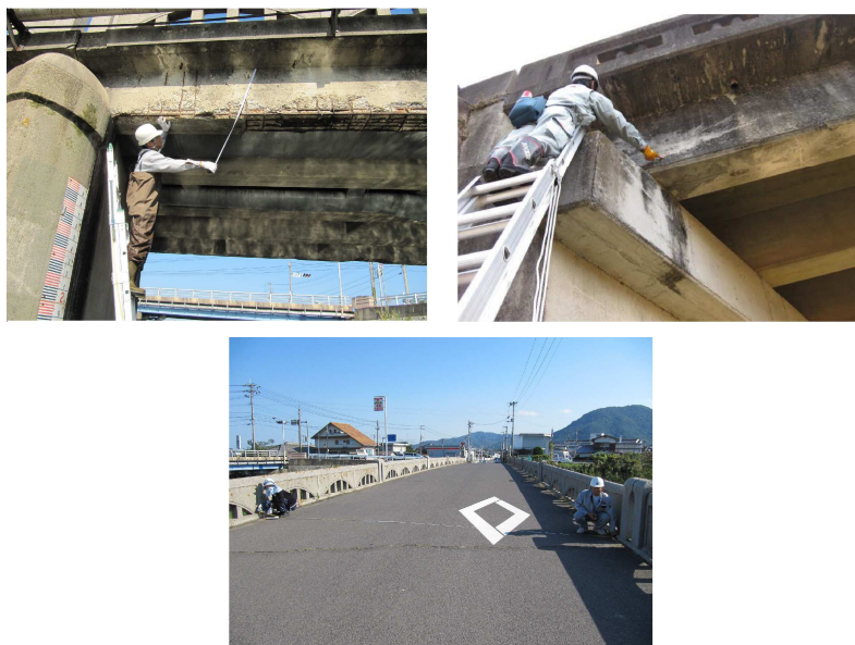
図 3.1 定期点検の様子
