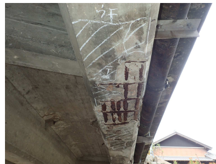
図 1.4 コンクリート橋の損傷
