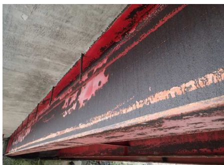
図 1.3 鋼橋の損傷状況
