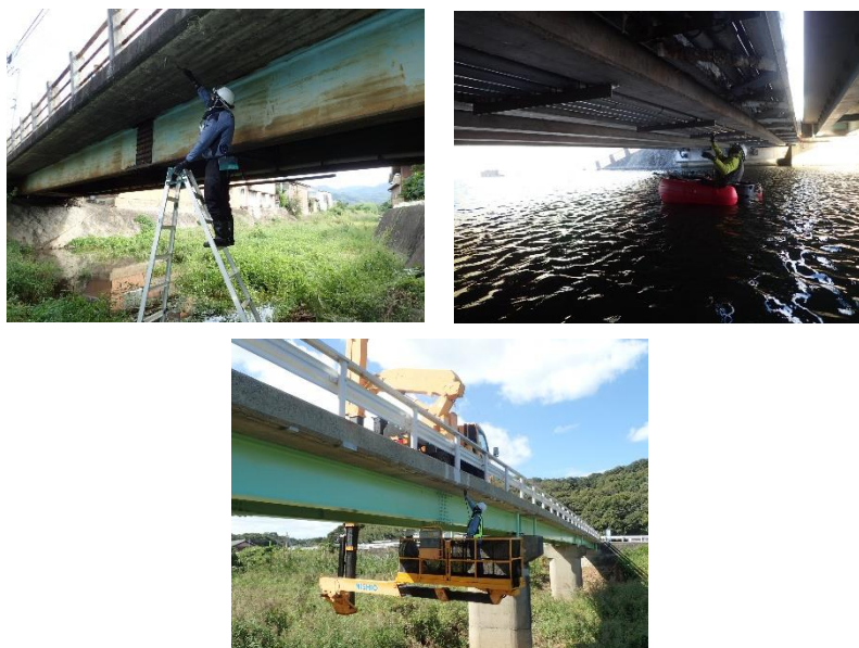
図 3.1 定期点検の様子
