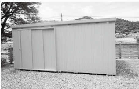
防災資機材保管用倉庫
