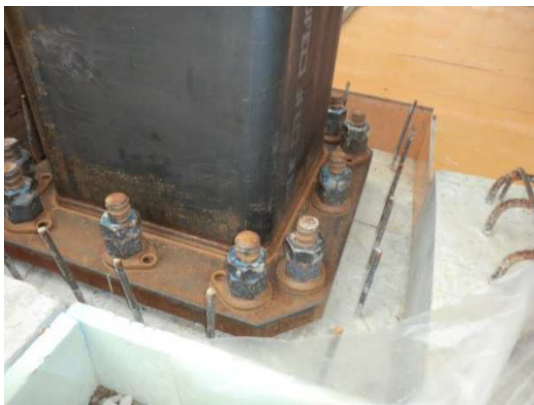
③ 鉄骨柱脚のベースパック工法
