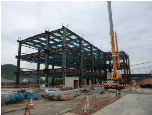
① 鉄骨建て方状況
