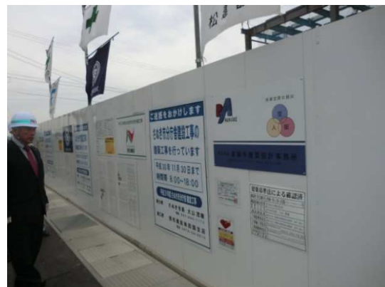
⑥ 仮囲い・掲示物の取付状況
