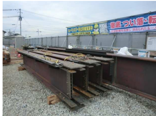
② 鉄骨柱と梁の接続箇所
