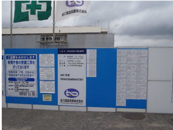
掲示物 建設業許可標識、労災保険関係成立票、 建退共制度の適用標識、施工体系図
