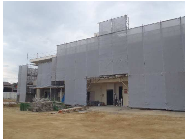
外部 東面 足場現況
