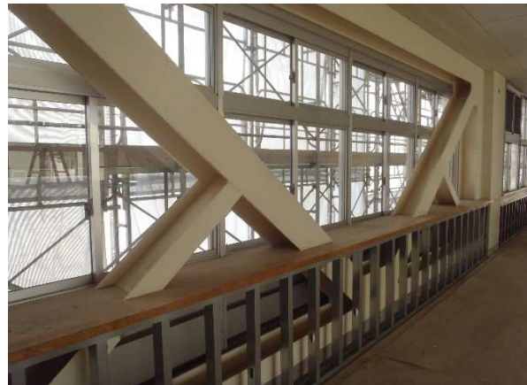
1階 廊下腰壁 現況
