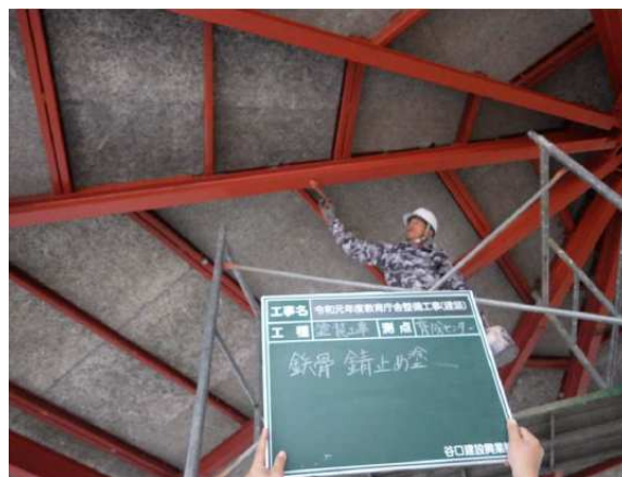
少年育成センター屋根架構鉄骨の錆止め
