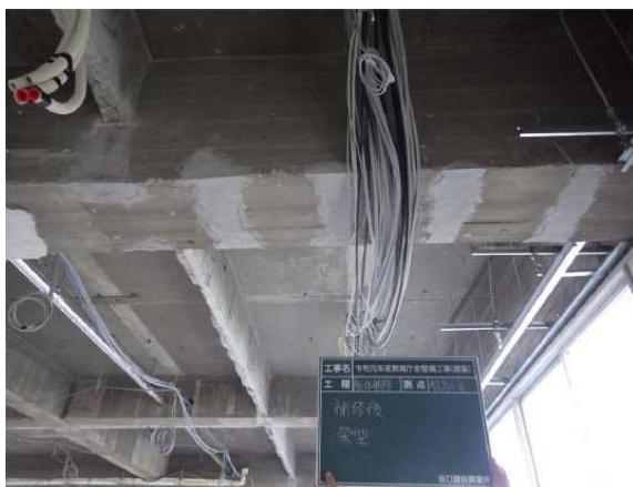
R C梁底欠損部分の補修
