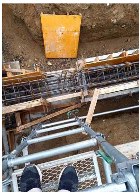
写真 15 基礎梁打継部
