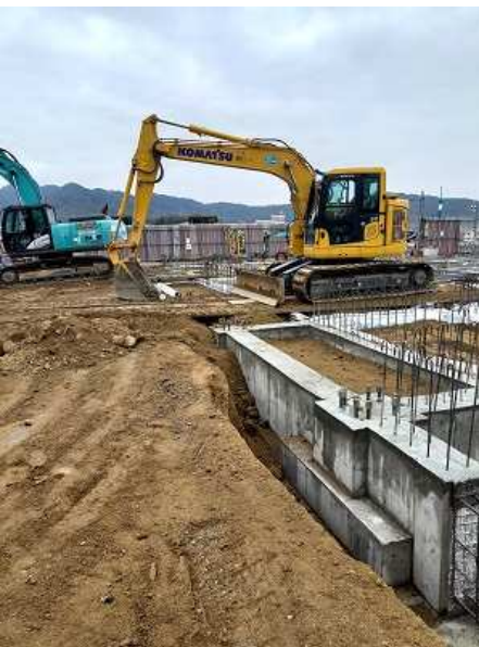
写真6 基礎地中梁埋め戻し
