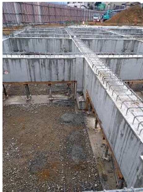
写真5 配管ピット部躯体出来形
