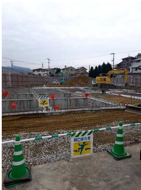
写真3 現場内の状況
