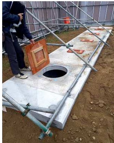
写真7 災害時便所埋設
