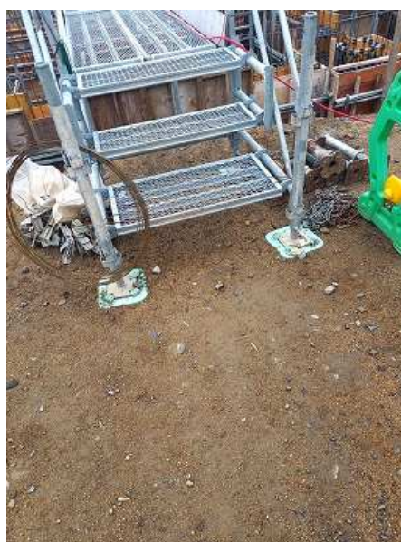
写真 13 通路足場昇降口
