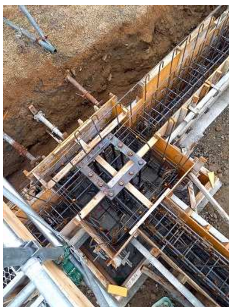
写真 14 鉄骨アンカーボルト埋め込み
