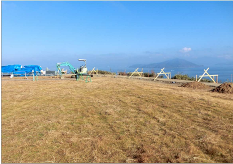
草つつみ施工状況
