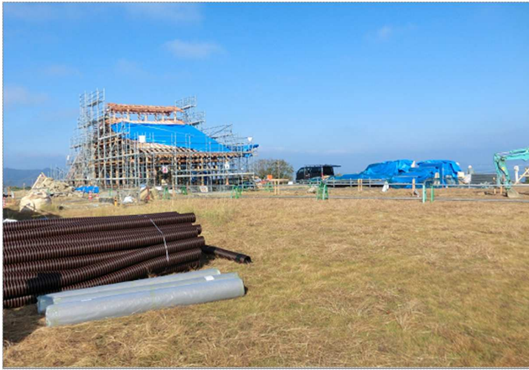
全景(南側より見る)
