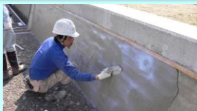
老朽化した水路壁のコーティング
