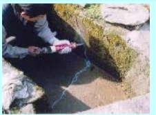
水路のひび割れ補修
