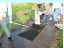
農道の部分補修
