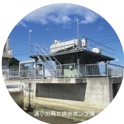
梅川雨水排水ポンプ場
