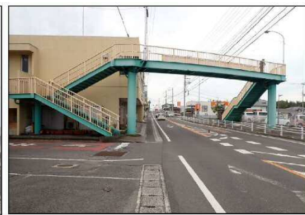
寒川横断歩道橋
