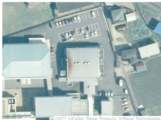
志度学校給食共同調理場 (中央正方形の建物)
